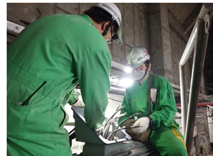
Fan Motor Replacement
